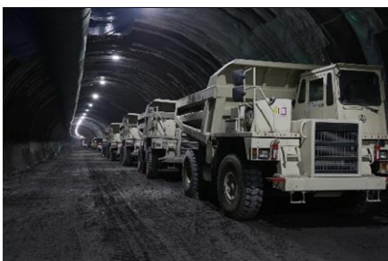
工事用機械の見学
